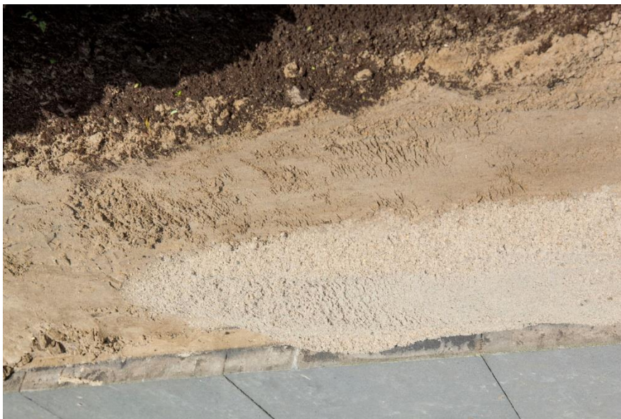
Foto: zandbed met daarop de straatlaag van metselzand doorgemengd met cement.
